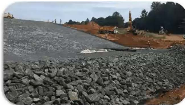
Hollymead Dam, VA
