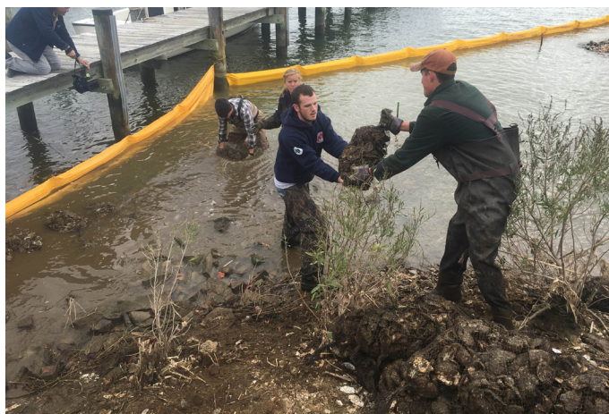
Construcción de una costa viviente en Maryland
